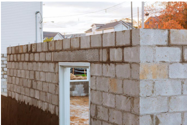
Abbildung 13 Betonmauerwerk
