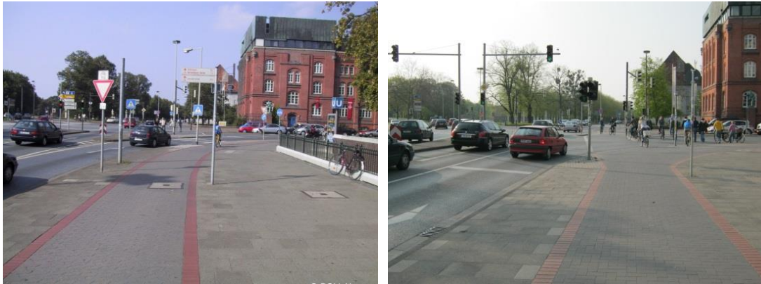
Abb. 5-19: Rückbau und Signalisierung eines konflikträchtigen freien Rechtsabbiegefahrstreifens in Hannover (links vorher, rechts nachher)
