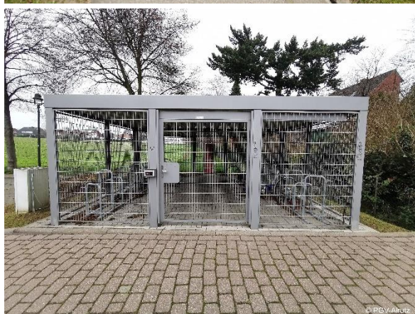
Westseite Bahnhof Ritterhude Sammelschließanlage mit E-Ladestation
