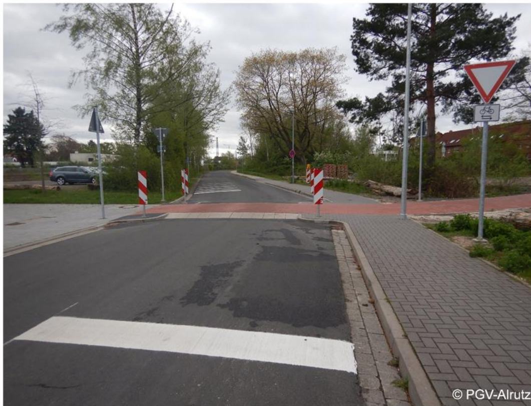
Abb. 5-30: Aufgepflasterte Querungsstelle – Neustadt am Rübenberge
