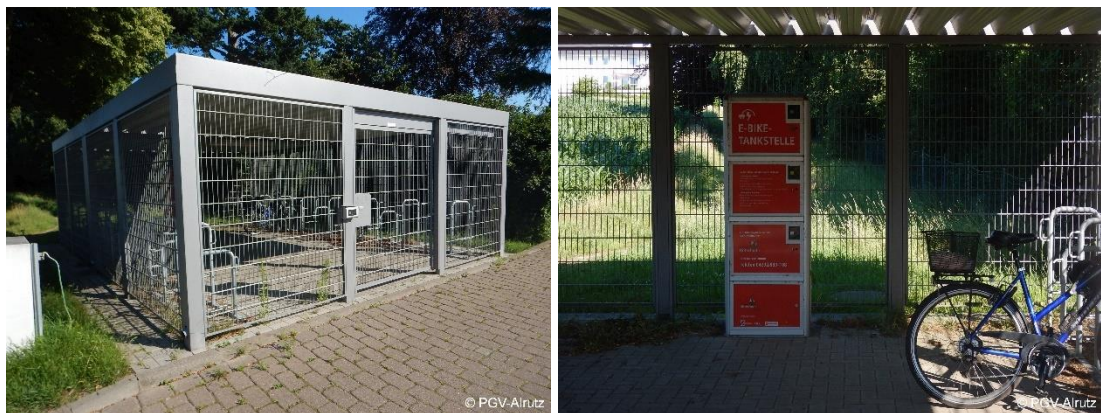
Abb. 6-3: Sammelschließanlage und Ladestation am Bahnhof Ritterhude
